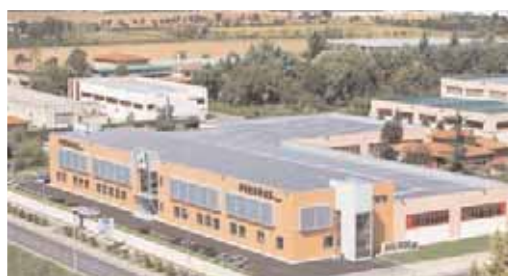
Veduta aerea della Pneumax a Lurano (BG).
